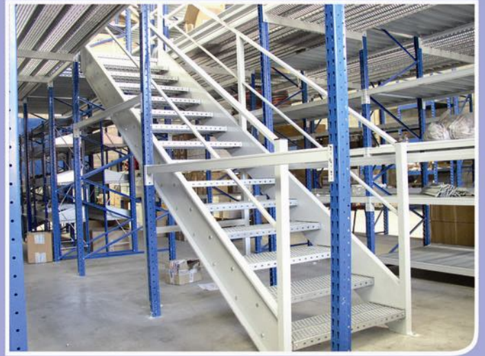
Particolare scala ad una rampa
