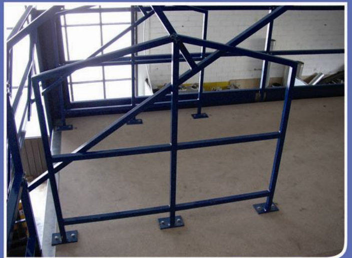
Particolare cancello basculante
