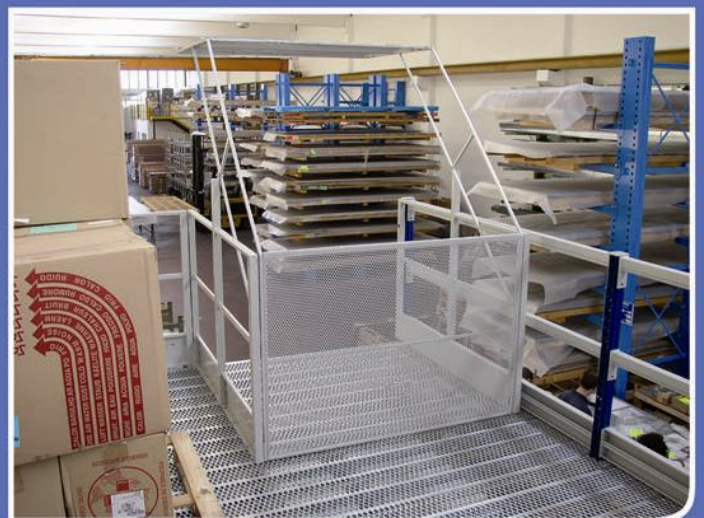
Particolare cancello basculante
