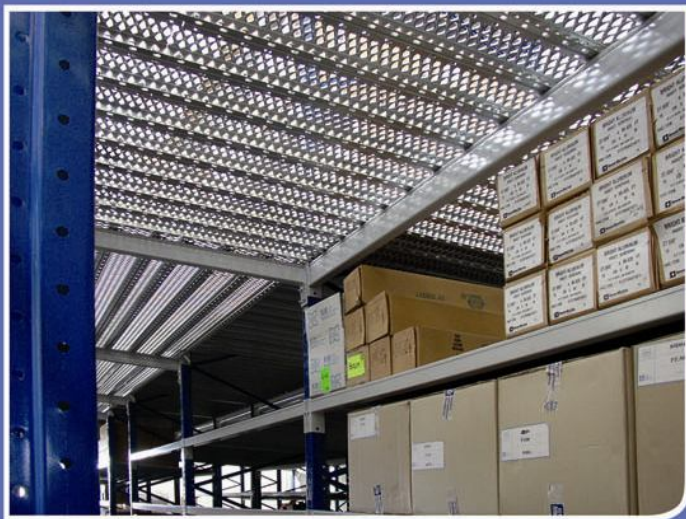
5 ■ Particolare travi porta grigliato
