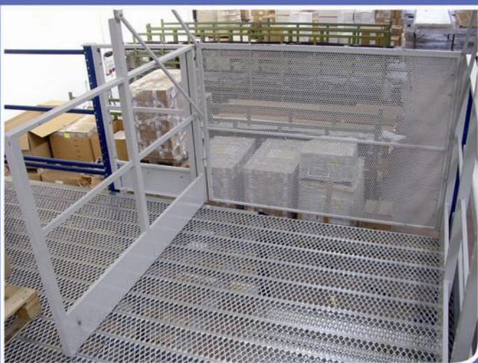
Particolare cancello basculante
